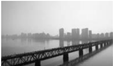
A. 钱塘江大桥
